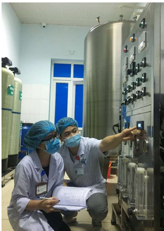
Kiểm tra, vận hành hệ thống RO
